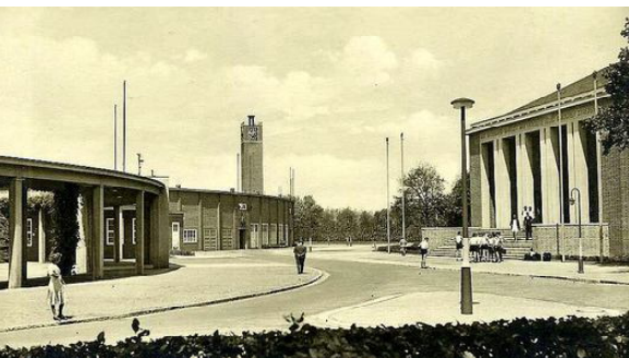
Widok na halę WOSS i część stadionu głównego
