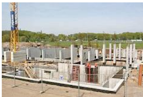
Widok placu budowy
