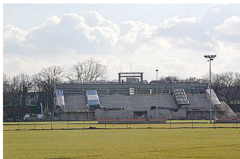
Obiekt na Polach Marsowych w obecnym stadium budowy
