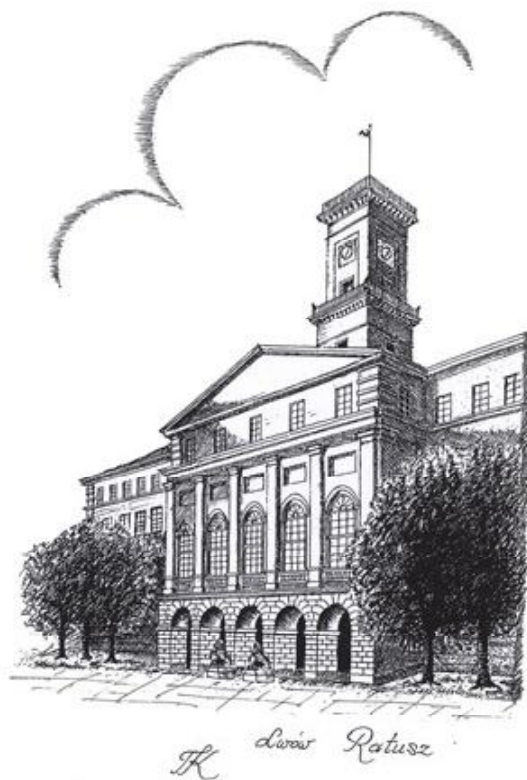
Ratusz lwowski zbudowany w stylu późno gotyckim w latach 1827-1835 przez Marka Merkla i Franciszka Tresela.
