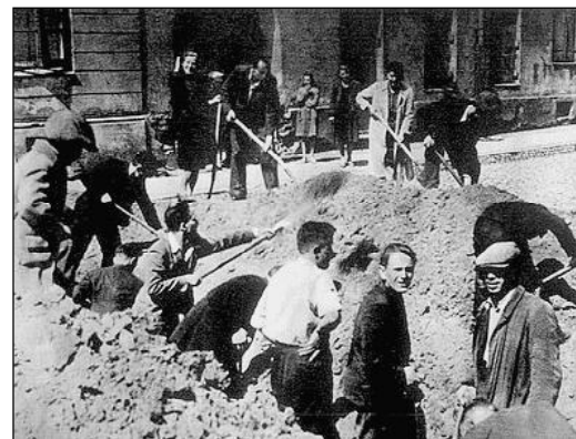
Budowa barykady na Woli
