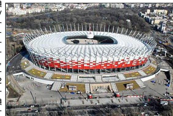
Dzisiejszy widok Stadionu Narodowego w Warszawie z lotu ptaka
